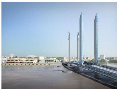
Le pont Jacques Chaban Delmas a une longueur de 575 mètres et un pont principal de 433 mètres. Sa travée levante de 117 mètres permet de préserver les trafics maritimes, fluviaux et événementiels. Ses pylônes changent de couleurs en fonction de la marée : bleu Outremer quand elle est haute, vert Véronèse à marée basse.
